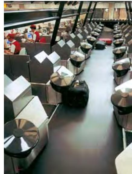
Приемный конвейер в зоне регистрации аэропорта. Плоская поверхность ленты обеспечивает плавную боковую загрузку багажа даже на широкую конвейерную ленту. Огнестойкость материалов – обязательное требование в современных аэропортах.
